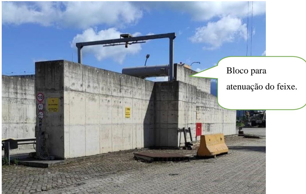
Figura 7: Bloco de Blindagem Atrás dos Braços do Detector.
