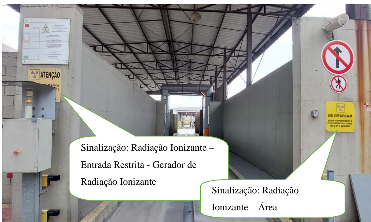
Figura 19: Sinalização com placas para outro tipo de instalação de cargas e contêineres.
