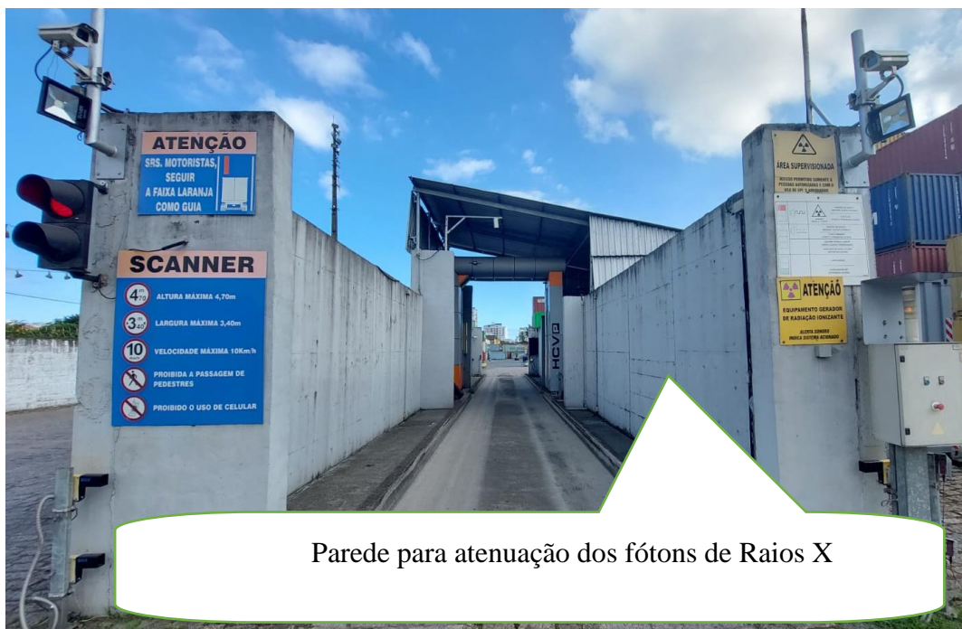
Figura 9: Exemplo de parede de blindagem em outra instalação de cargas e contêineres.
